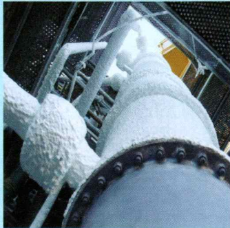
防止煙囪管道內外因為溫差而產生冷凝的目的。
