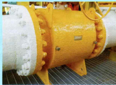
海面上石油管線利用陶瓷保溫塗料維持內部溫度，不受海上氣溫變化影響，維持設備正常運作。
